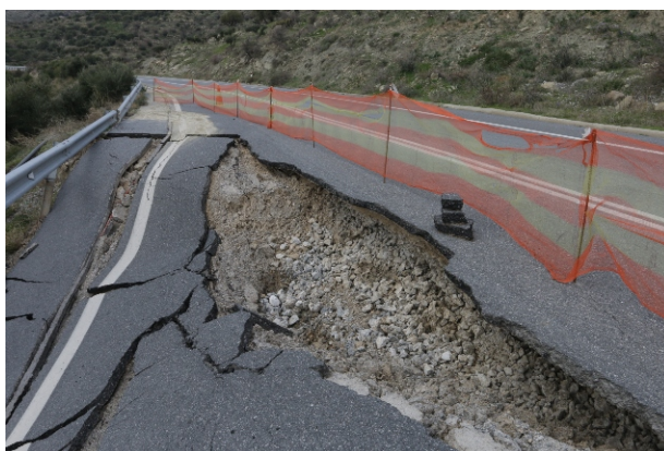
Εικόνα 3.18: Καθίζηση στο οδικό δίκτυο της Κρήτης, στη περιοχή της Κάτω Βιάννου, ύστερα από ρευστοποίηση της εδαφικής μάζας ( www.creteplus.gr ).
