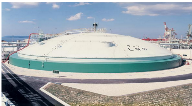
Εικόνα 2.7: Υπόγεια δεξαμενή αποθήκευσης ΥΦΑ ( www.siwx.co.jp ).
