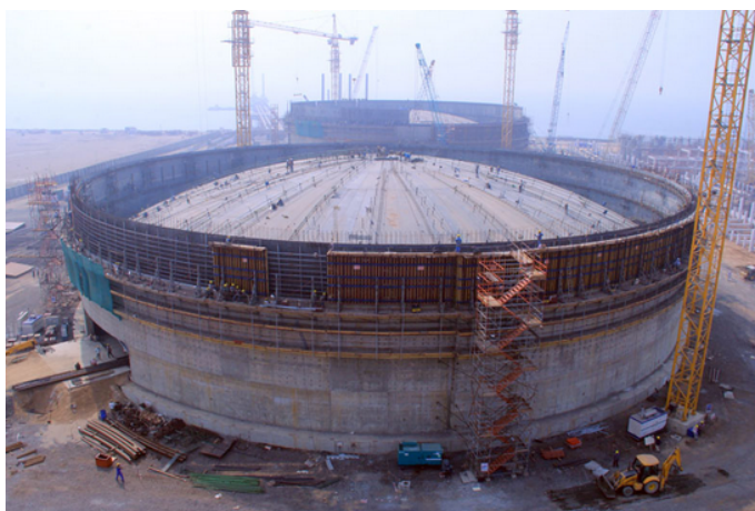
Εικόνα 2.9: Ανέγερση δεξαμενής Αποθήκευσης ΥΦΑ στον τερματικό σταθμό της Μούνδρας στην Ινδία. Η οροφή ανυψώνεται με την κατασκευή του κελύφους ( www.itdcem.co.in ).
