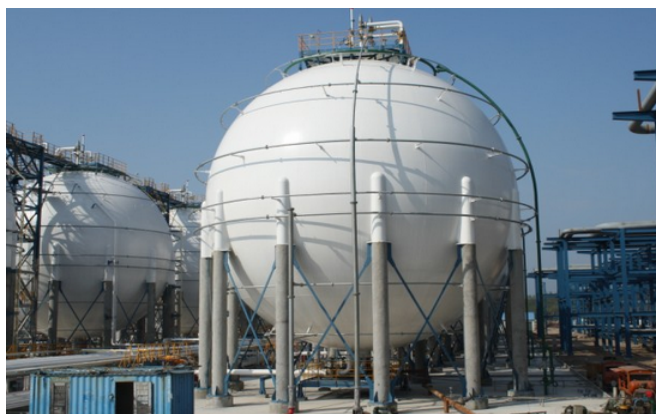
Εικόνα 2.6: Σφαιρική υπερυψωμένη δεξαμενή αποθήκευσης ΥΦΑ ( www.stonefitting.cn ).
