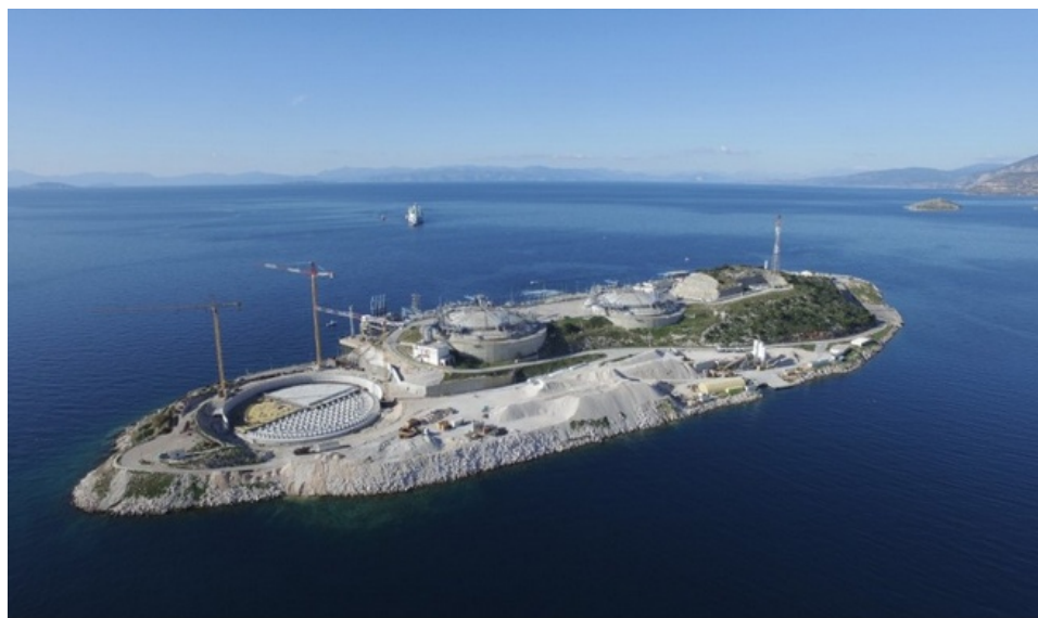
Εικόνα 1.6: Άποψη από τον τερματικό σταθμό ΥΦΑ στην νήσο Ρεβυθούσα. Αριστερά στην εικόνα διακρίνεται η ανέγερση της τρίτης δεξαμενής αποθήκευσης ΥΦΑ ( www.newpost.gr ).
