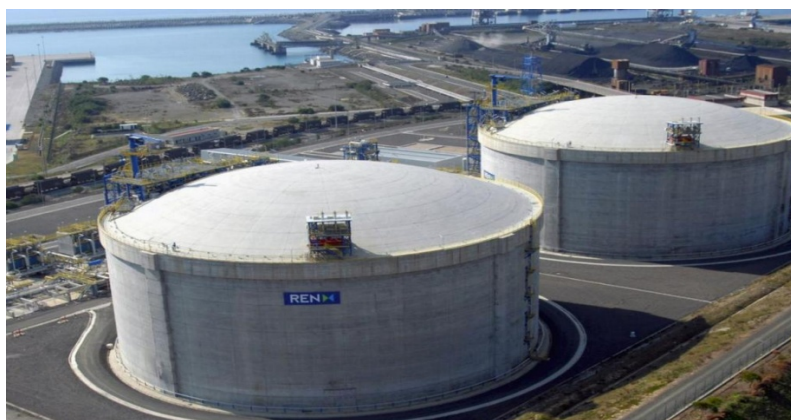
Εικόνα 2.3: Επίγειες δεξαμενές αποθήκευσης ΥΦΑ, πλήρους συγκράτησης ( www.financialtribute.com ).
