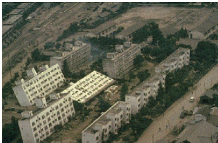
Εικόνα 3.12: Αστοχίες στις θεμελιώσεις κτιρίων ύστερα από ρευστοποίηση εδάφους, στο σεισμό της Ναγκάτα (1964) [ www.theconstructor.org ].
