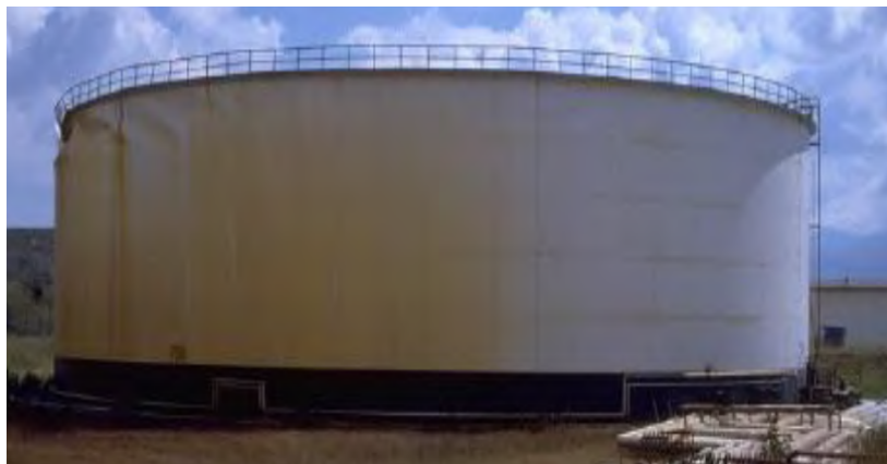
Εικόνα 2.15: Λυγισμός δεξαμενής τύπου “diamond shape” στο πάνω αριστερό μέρος της δεξαμενής (Νικολάου, 2016).
