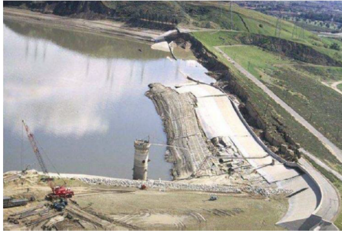
Εικόνα 3.13: Αστοχία φράγματος San Fernando λόγω ρευστοποίησης ροής ( www.researchgate.net ).
