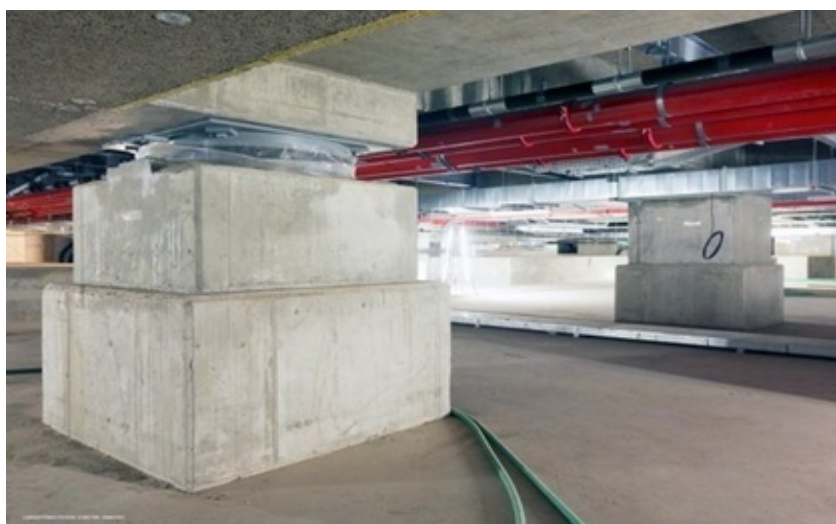
Εικόνα 3.25: Τοποθέτηση μονωτήρων τύπου FPS στο πάρκο Νιάρχος στην Αθήνα ( www.b2green.gr ).
