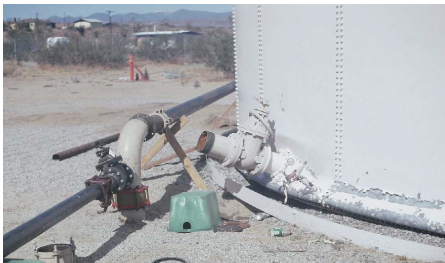
Εικόνα 2.17: Αστοχία σε ακροφύσιο και δίκτυο σωληνώσεων, λόγω λυγισμού της μορφής “elephant foot” και ανύψωση της βάσης (www3.apwa.net).
