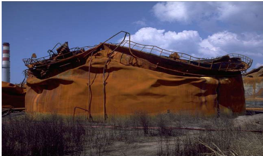
Εικόνα 2.19: Πρόκληση πυρκαγιάς σε δεξαμενή αποθήκευσης ( www.ogfj.com ).
