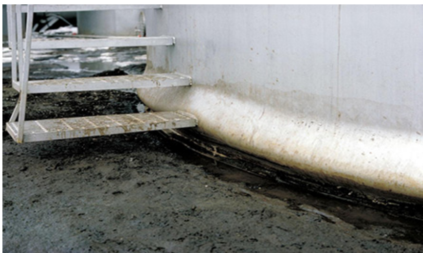
Εικόνα 2.14: Λυγισμός δεξαμενής τύπου “elephant foot” στη βάση
