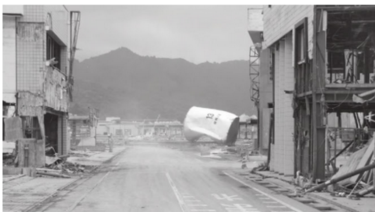
Εικόνα 2.12 : Ολίσθηση και ολοσχερή καταστροφή δεξαμενής στην περιφέρεια Μιγιάγκι στη Ιαπωνία κατά τη διάρκεια του Τσουνάμι το 2011 (Cruz et al., 2017).
