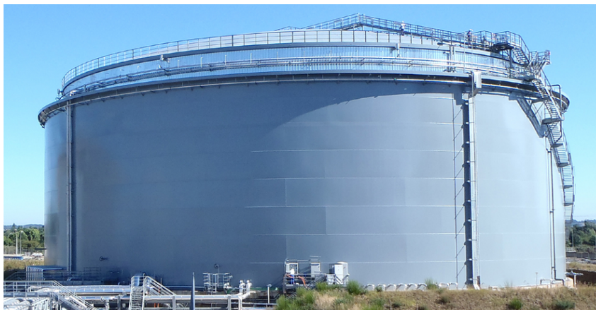
Εικόνα 2.2: Επίγεια δεξαμενή αποθήκευσης διπλής συγκράτησης ( www.desde.com ).
